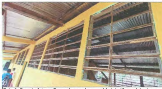
Foto 6: En esta fotografía se observa la necesidad de lijar y pintar los balcones del módulo 2 que se encuentran en malas condiciones.
